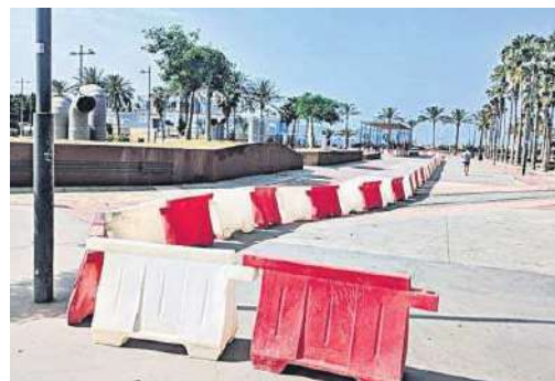
Carriles provisionales divididos en el interior de Las Almadrabillas.
