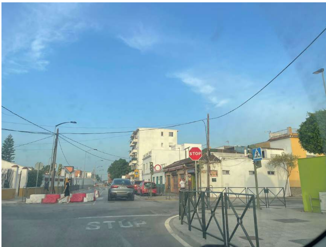
El Ayuntamiento informa del comienzo de la segunda fase de la avenida Diputación
