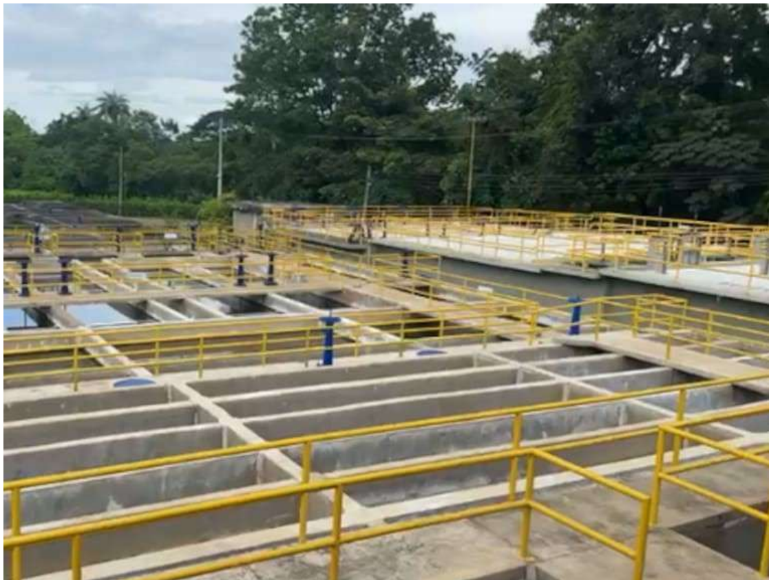
Planta de Tratamiento de Agua Potable. Foto: cortesía Aqualia.
